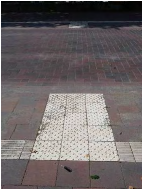
Bild 7: Markierte Querungsstelle in Bohmte, Detail Noppenplatten (Foto: Leven)
