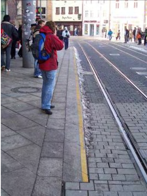
Bild 11: Nachträgliche Markierung einer Haltestelle in städtebaulich hochwertigem Bereich in Erfurt (Foto: Boenke)
