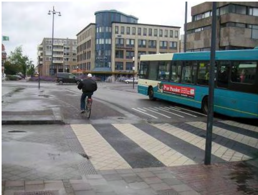
Bild 14: Querungshilfe bzw. Führung der Fußgänger/innen am Laweiplein in Drachten
