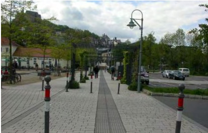
Bild 3: Gut ertastbares taktiler Leitsystem aus Rippenplatten (Foto: Rebstock)
