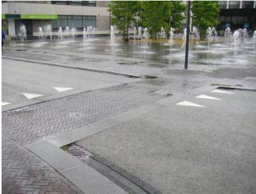
Bild 13: Querungshilfe bzw. Führung der Radfahrer/innen am Laweiplein in Drachten
