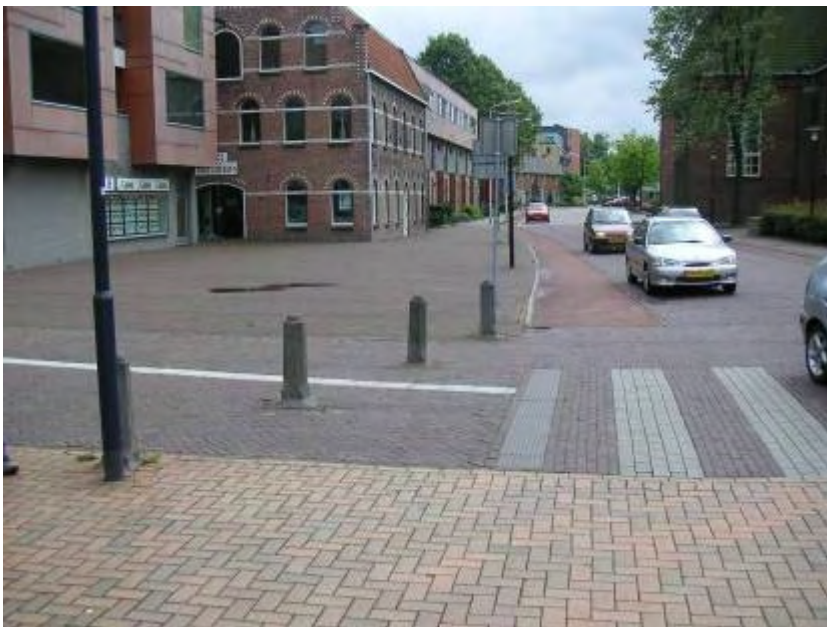
Bild 18: Knotenpunktzufahrt Torenstraat mit Fußgängerüberweg und Radfahrstreifen [1]
