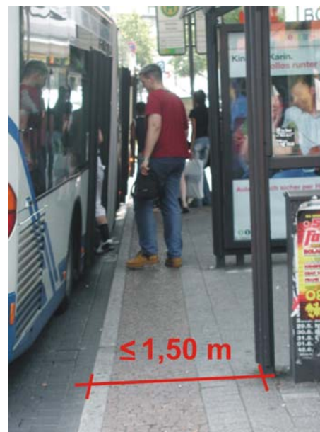
Bild 2: Unterschreitung der Mindestabmessung
