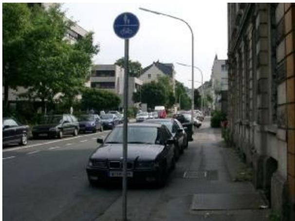
Abbildung 8: Unterdimensionierung und fehlerhafte Ausweisung der Benutzungspflicht eines Geh- und Radweges
