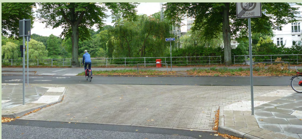
Abbildung 29: Gehwegüberfahrt am Leinpfad in Hamburg.
